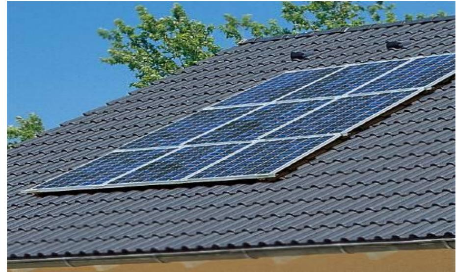
Photovoltaik: Solarzellen wandeln Strahlungsenergie in elektrische Energie um
